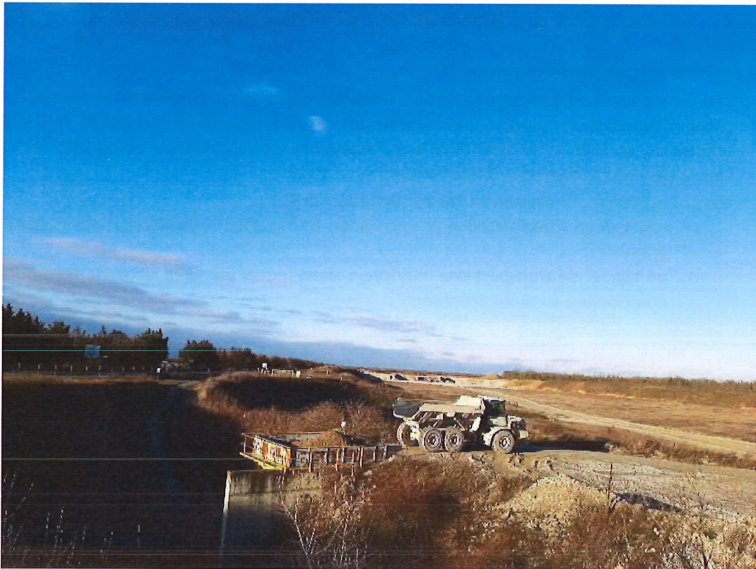
Figure 5 : Trémie de chargement de la bande transporteuse (visite Antea Group du 19/01/2022)
